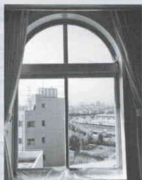
①窓ガラスに養生する
