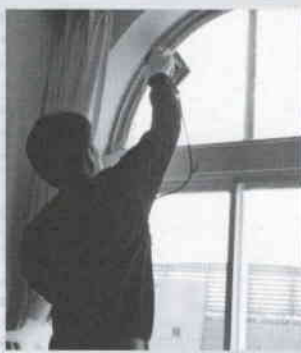
③研磨後、スポンジに水を付けてガラスを磨いて清掃する。清掃後、完全に水分を除去する
