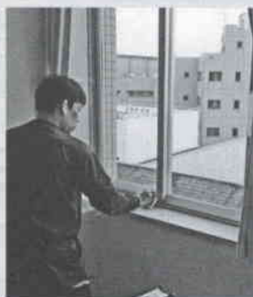
③研磨後、スポンジに水を付けてガラスを磨いて清掃する。清掃後、完全に水分を除去する
