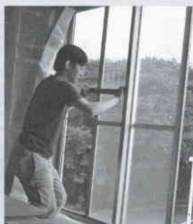
写真1 窓ガラス面への遮熱コーティング
